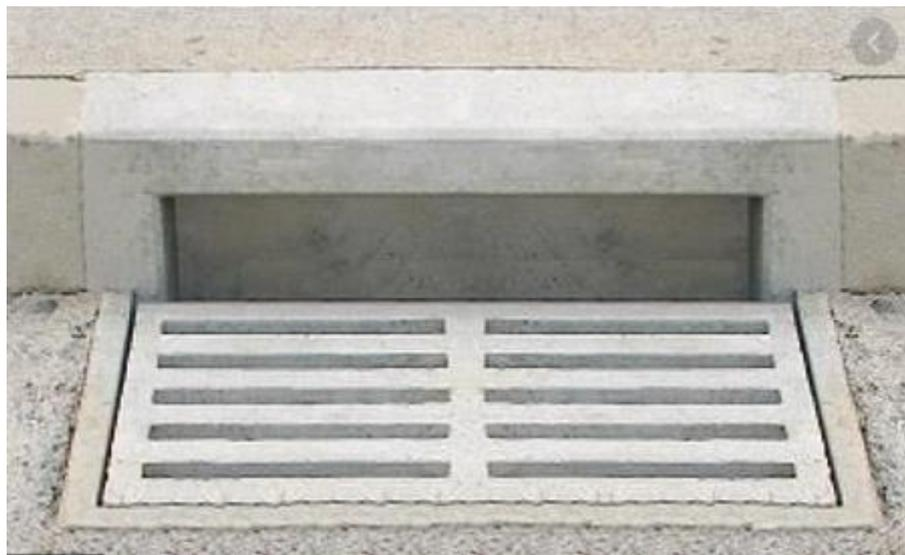
Figura 1: Detalhe da boca de lobo a ser executada
