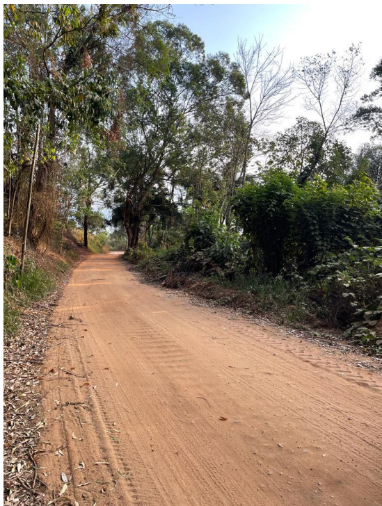
Foto 6: Vista próxima da estaca E12.
