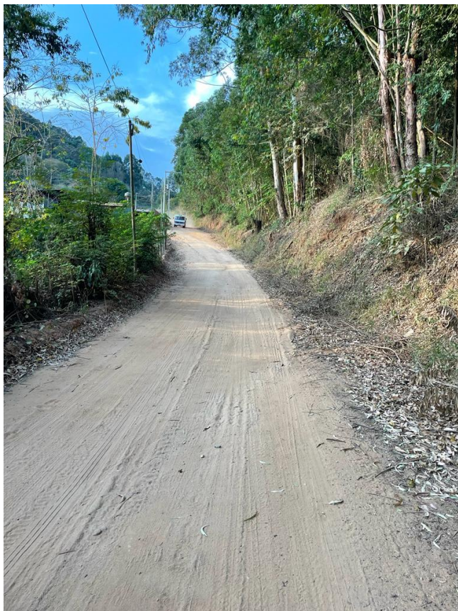
Foto 5: Vista próxima da estaca E10.
