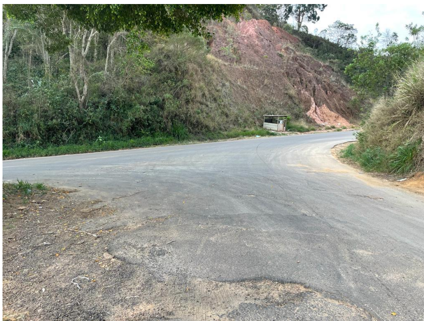
Foto 1 : início do calçameto vista da BR-482 .
