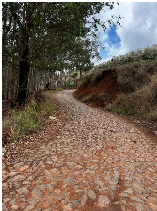
FOTO 8 : VISTA PROXIMO A ESTACA 114
