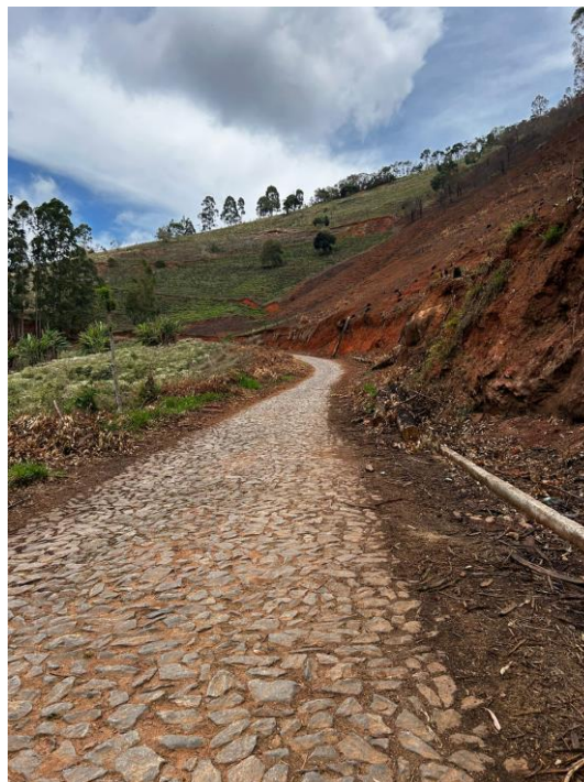
FOTO 4 : VISTA PROXIMO A ESTACA 106
