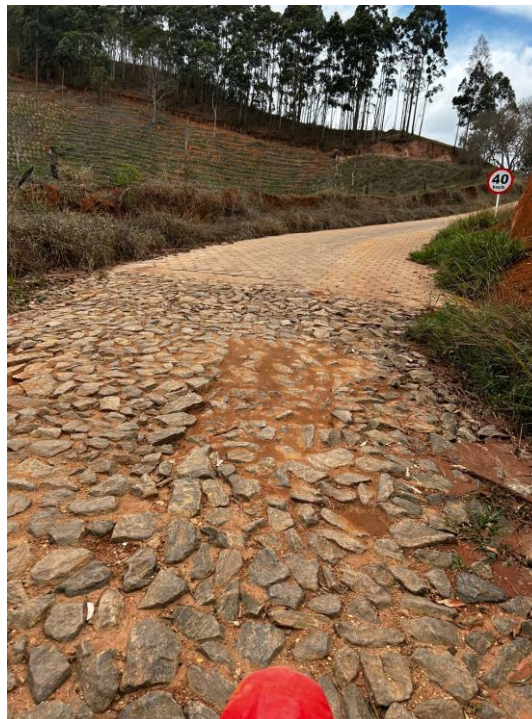
FOTO 12 : VISTA PROXIMO A ESTACA 116
