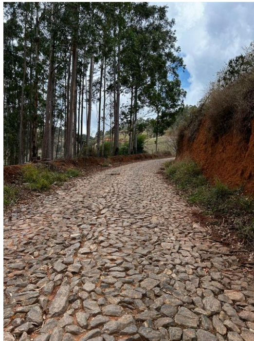
FOTO 10 : VISTA PROXIMO A ESTACA 112
