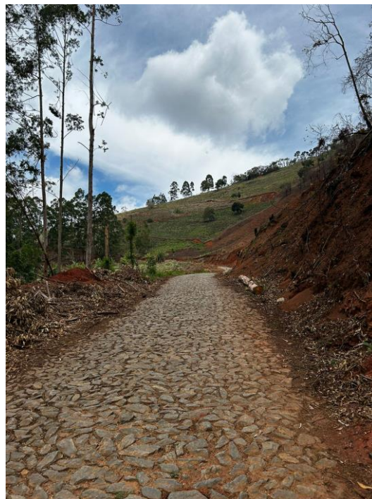
FOTO 2 : VISTA PROXIMO A ESTACA 102
