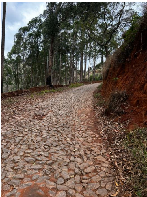
FOTO 9 : VISTA PROXIMO A ESTACA 110
