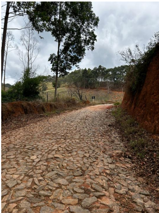
FOTO 11 : VISTA PROXIMO A ESTACA 115
