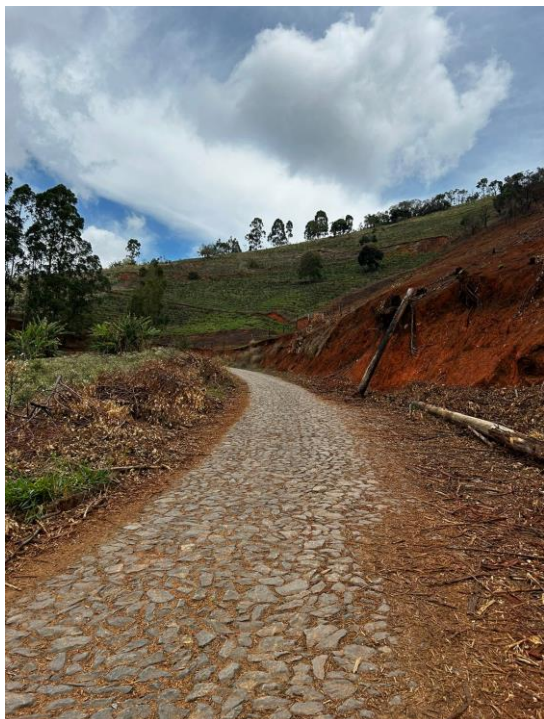
FOTO 3 : VISTA PROXIMO A ESTACA 104
