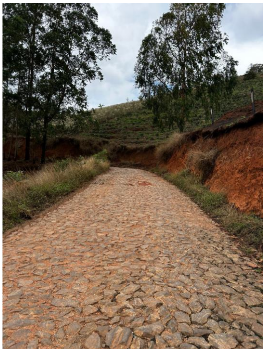
FOTO 7 : VISTA PROXIMO A ESTACA 112
