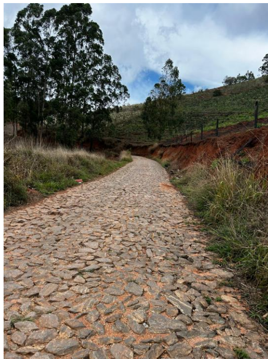
FOTO 6 : VISTA PROXIMO A ESTACA 110
