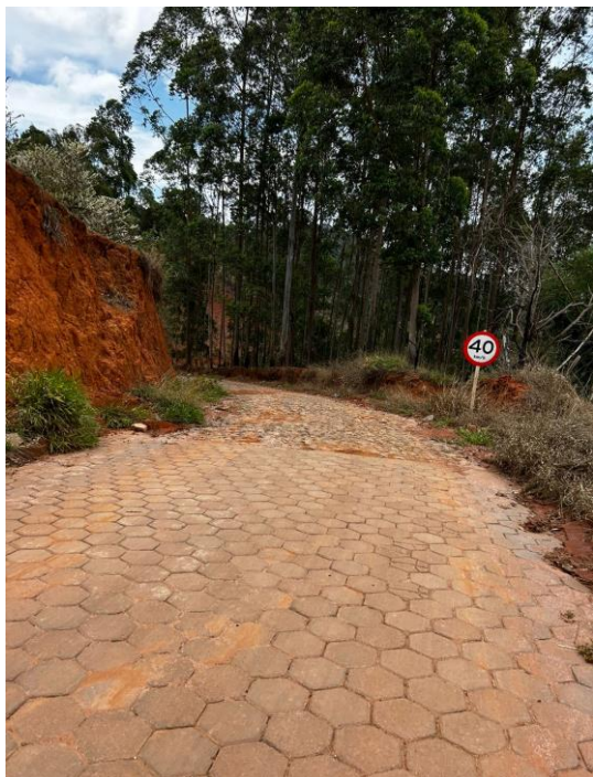
FOTO 13 : VISTA PROXIMO A ESTACA 117
