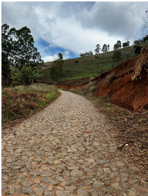
FOTO 5 : VISTA PROXIMO A ESTACA 109
