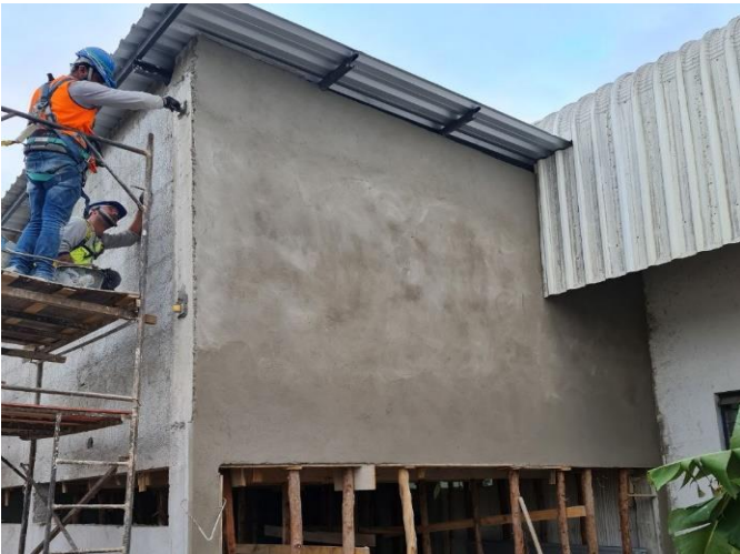
Foto 25 – Alvenaria mezanino – Bloco de Apoio
