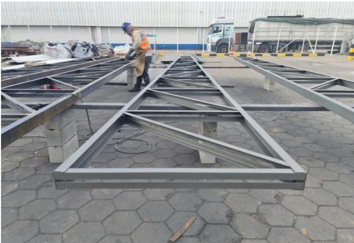
Foto 9 – Execução de estrutura metálica telhado - Galpão
