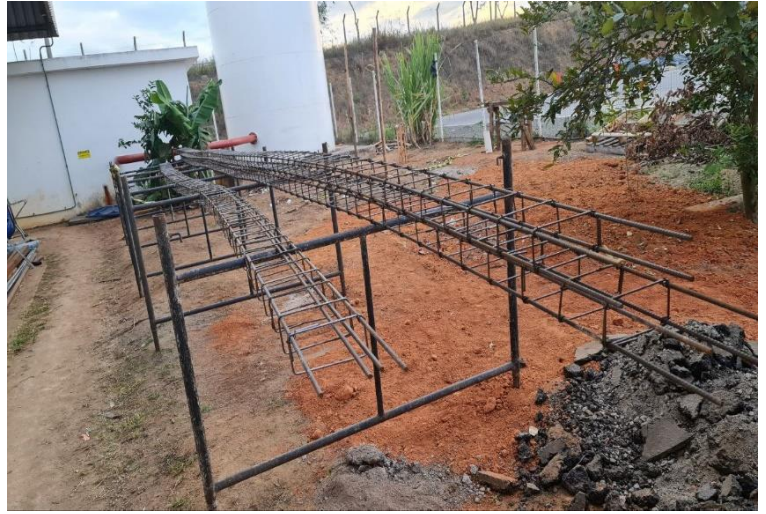
Foto 2 - Início de execução de pilares e alvenaria- Galpão
