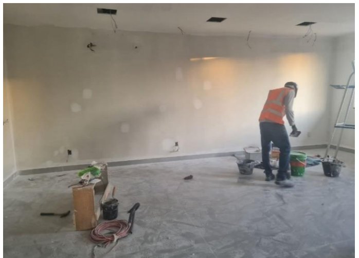
Foto 30 – Execução de pintura
