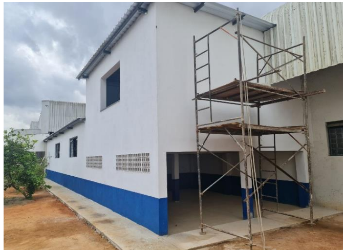
Foto 64 – Pintura externa Bloco de Apoio
