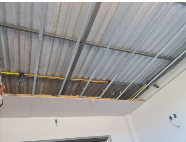
Foto 45 – Execução de forro em gesso mezanino
