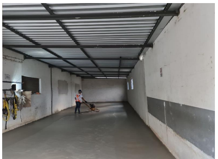
Foto 54 – Execução piso em concreto polido – Bloco de apoio
