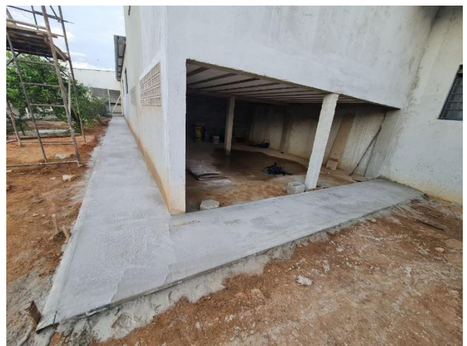
Foto 60 – Execução de passeio – Bloco de apoio
