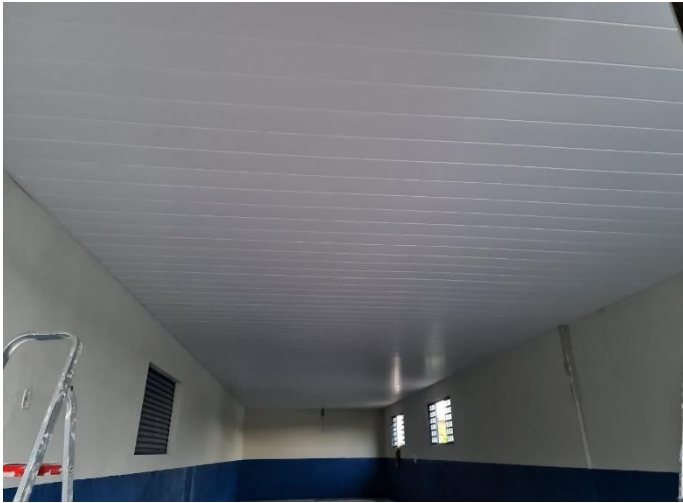
Foto 67 – Execução de forro em PVC
