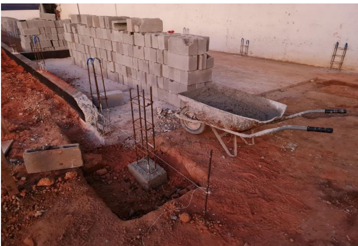
Foto 11 – Execução Alvenaria e pilar – Bloco de Apoio
