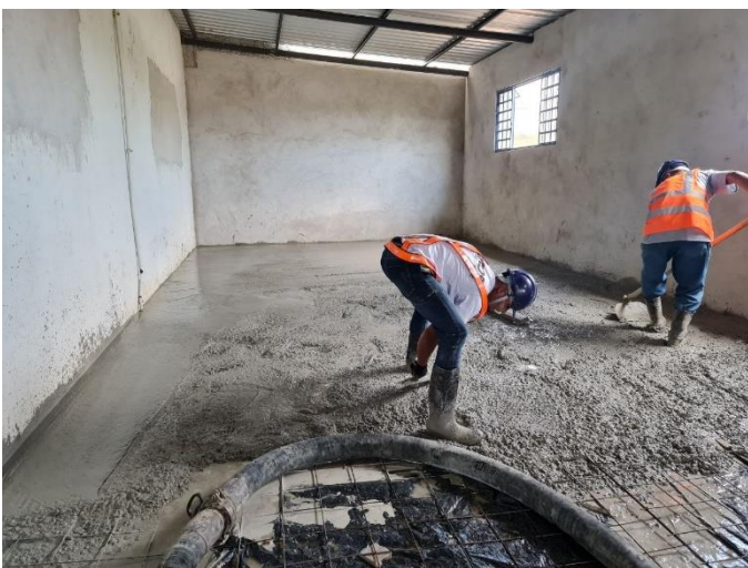
Foto 53 – Execução laje de transição – Bloco de Apoio
