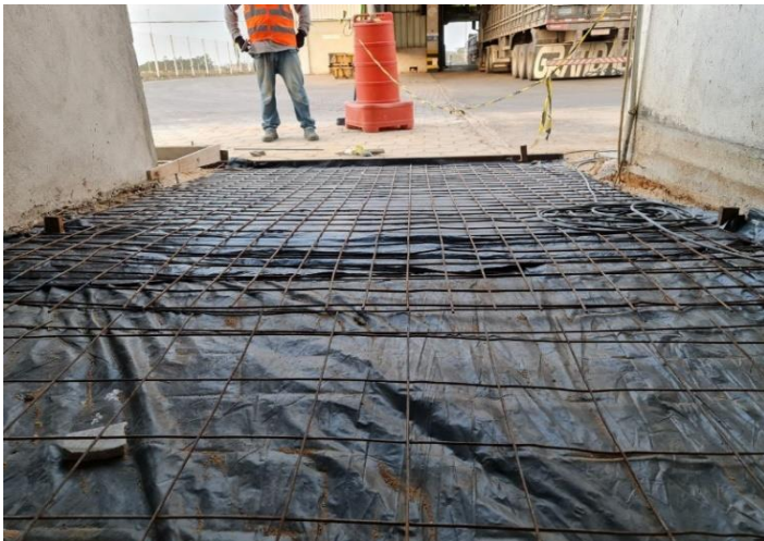
Foto 53 – Execução laje de transição – Bloco de Apoio
