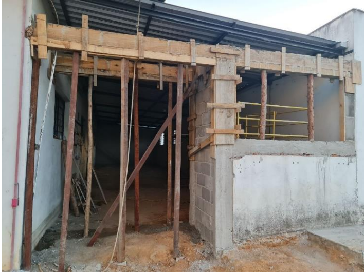
Foto 51 – Execução laje de transição – Bloco de Apoio
