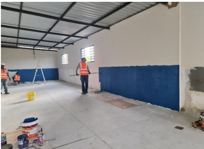
Foto 63 – Pintura interna Bloco de Apoio
