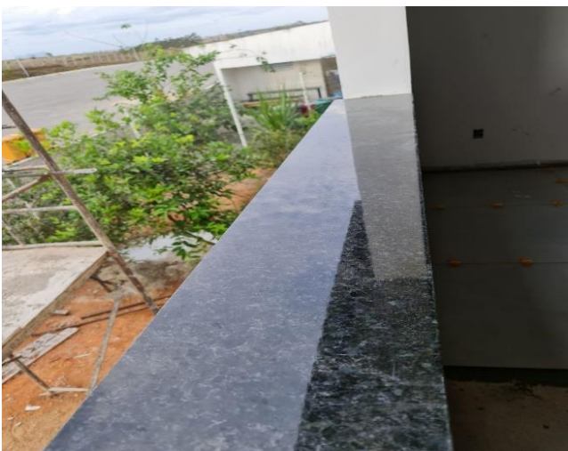
Foto 59 – Instalação de pedras – Bloco de Apoio
