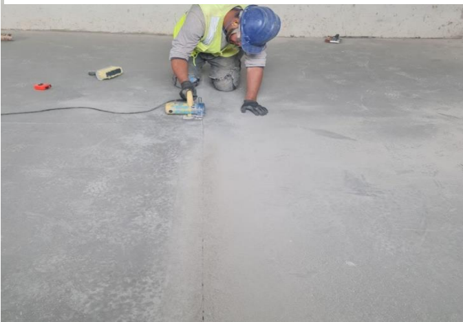
Foto 35 - Execução piso em concreto polido – Bloco de apoio
