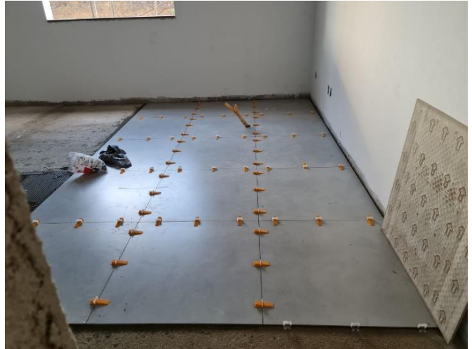
Foto 58 – Instalação de piso cerâmico mezanino- Bloco de Apoio
