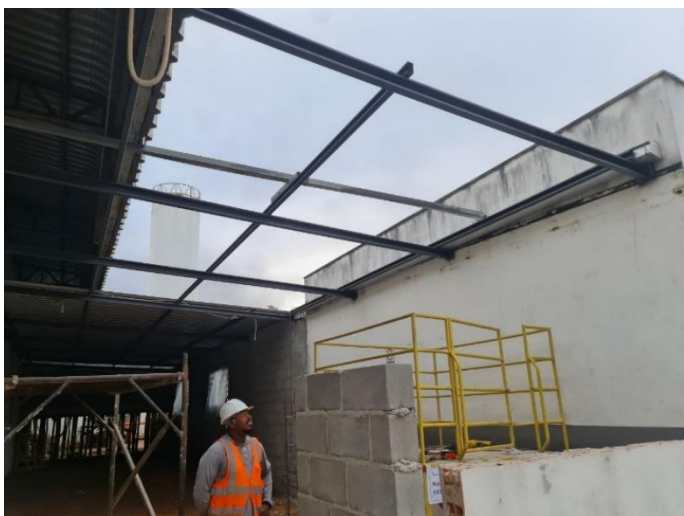
Foto 35 – Execução de cobertura metálica – Bloco de Apoio
