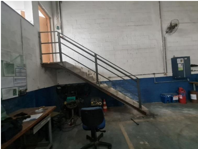
Foto 69 – Execução de corrimão escada mezanino
