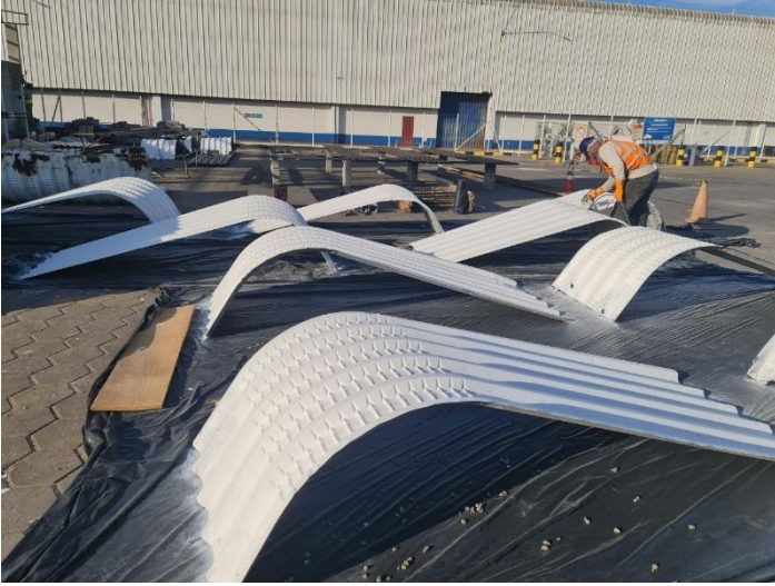
Foto 13 – Dobra de telha para telhamento lateral - Galpão
