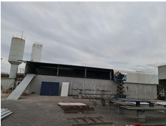
Foto 23 – Instalação telha lateral e cobertura - Galpão
