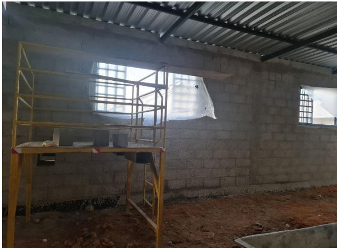
Foto 27 – Alvenaria Bloco de Apoio
