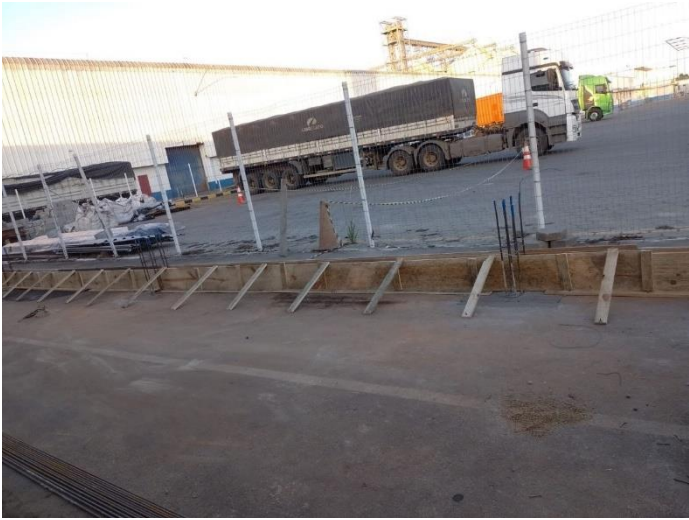
Foto 1-Execução viga baldrame -Galpão
