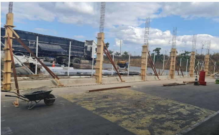
Foto 5 - Execução de pilares - Galpão
