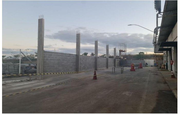
Foto 8– Execução de alvenaria - Galpão
