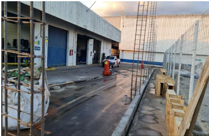
Foto 3- Execução Pilares e alvenaria - Galpão
