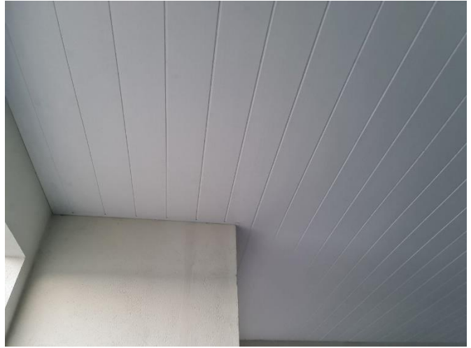
Foto 68 – Execução e forro em PVC
