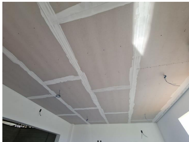
Foto 66- Execução de forro em gesso mezanino
