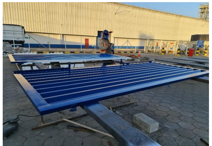
Foto 16 – Fabricação de esquadrias
