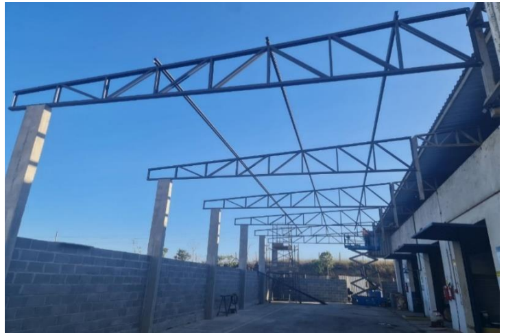
Foto 10 – Posicionamento e soldagem das terças do telhado
