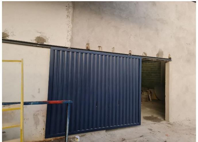
Foto 28 – Instalação de portão metálico
