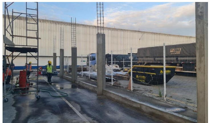
Foto 6 - Execução de pilares - Galpão
