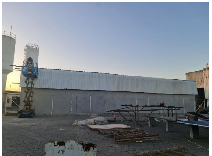
Foto 24 - Instalação telha lateral e cobertura - Galpão
