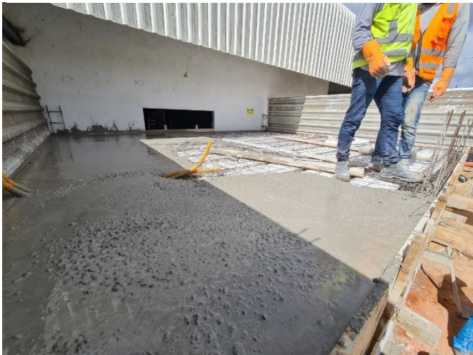
Foto 21 – Concretagem de laje - Mezanino
