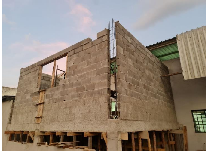
Foto 26 – Alvenaria mezanino – Bloco de Apoio
