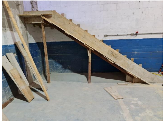
Foto 48- Execução de escada de acesso ao mezanino
