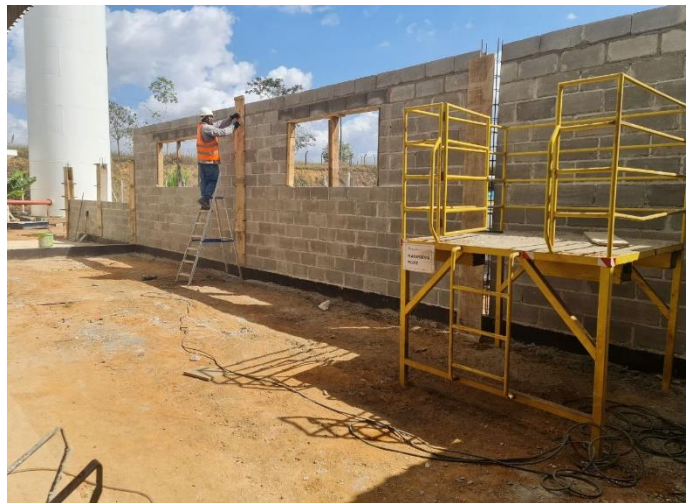
Foto 12 – Execução de alvenaria e pilarres – Bloco de Apoio
