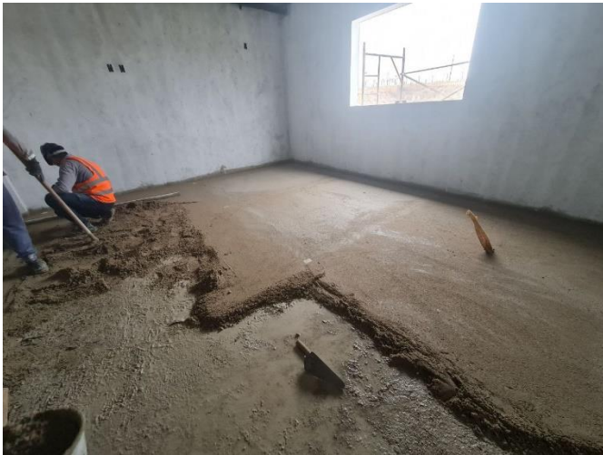
Foto 57 – Execução de contrapiso mezanino – Bloco de Apoio
