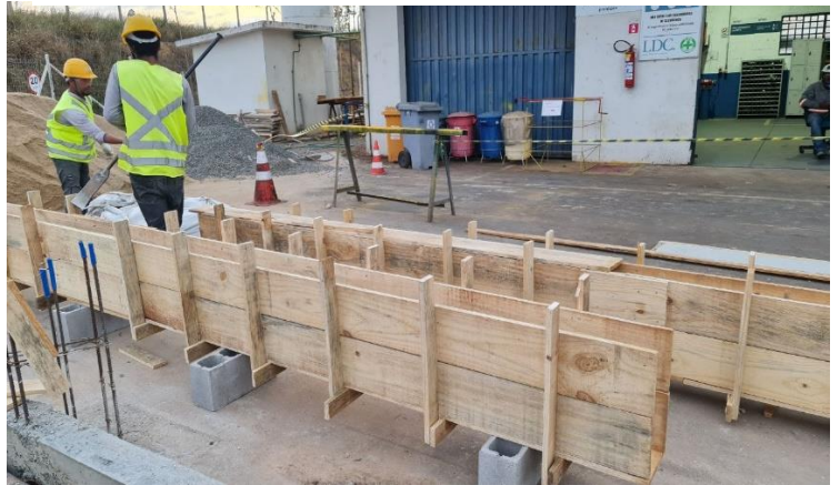
Foto 4- Fabricação de formas para pilar - Galpão
