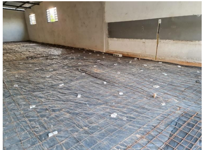
Foto 52 – Execução laje de transição
