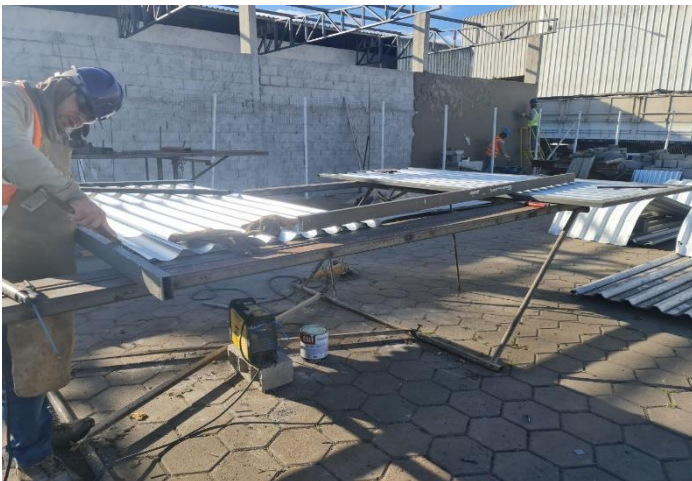
Foto 15 – Fabricação de esquadrias
