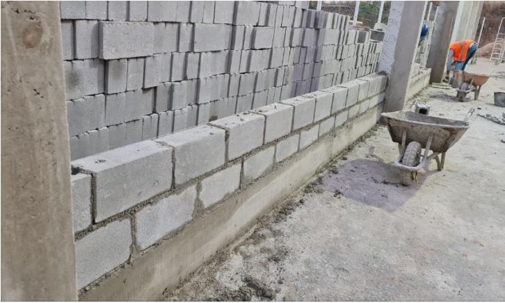
Foto 7- Execução de alvenaria – Galpão
