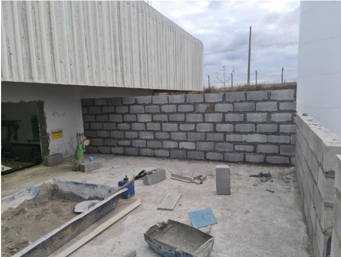
Foto 25 – Alvenaria mezanino – Bloco de Apoio
