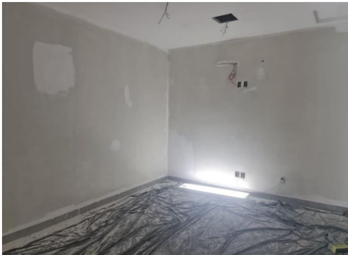
Foto 29 – Execução de pintura
