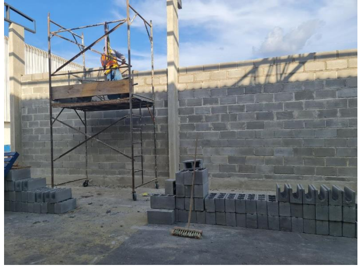
Foto 14 – Execução alvenaria - Galpão
