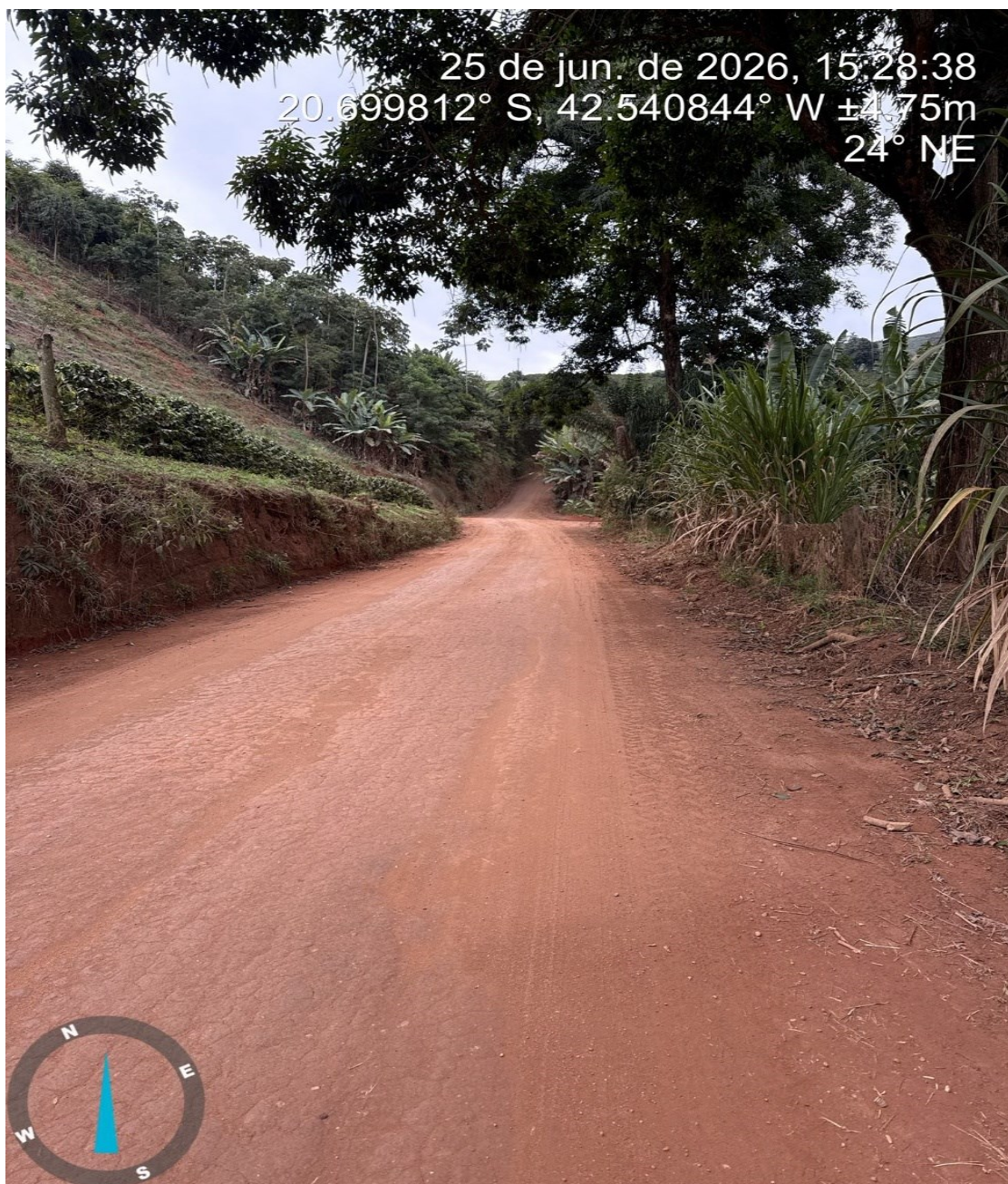
Foto 01 - Trecho inicial da via
