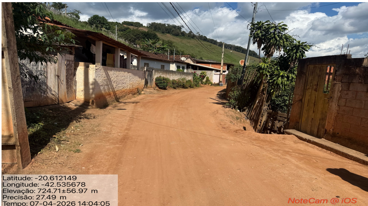
Foto 04 - Continuação da via
