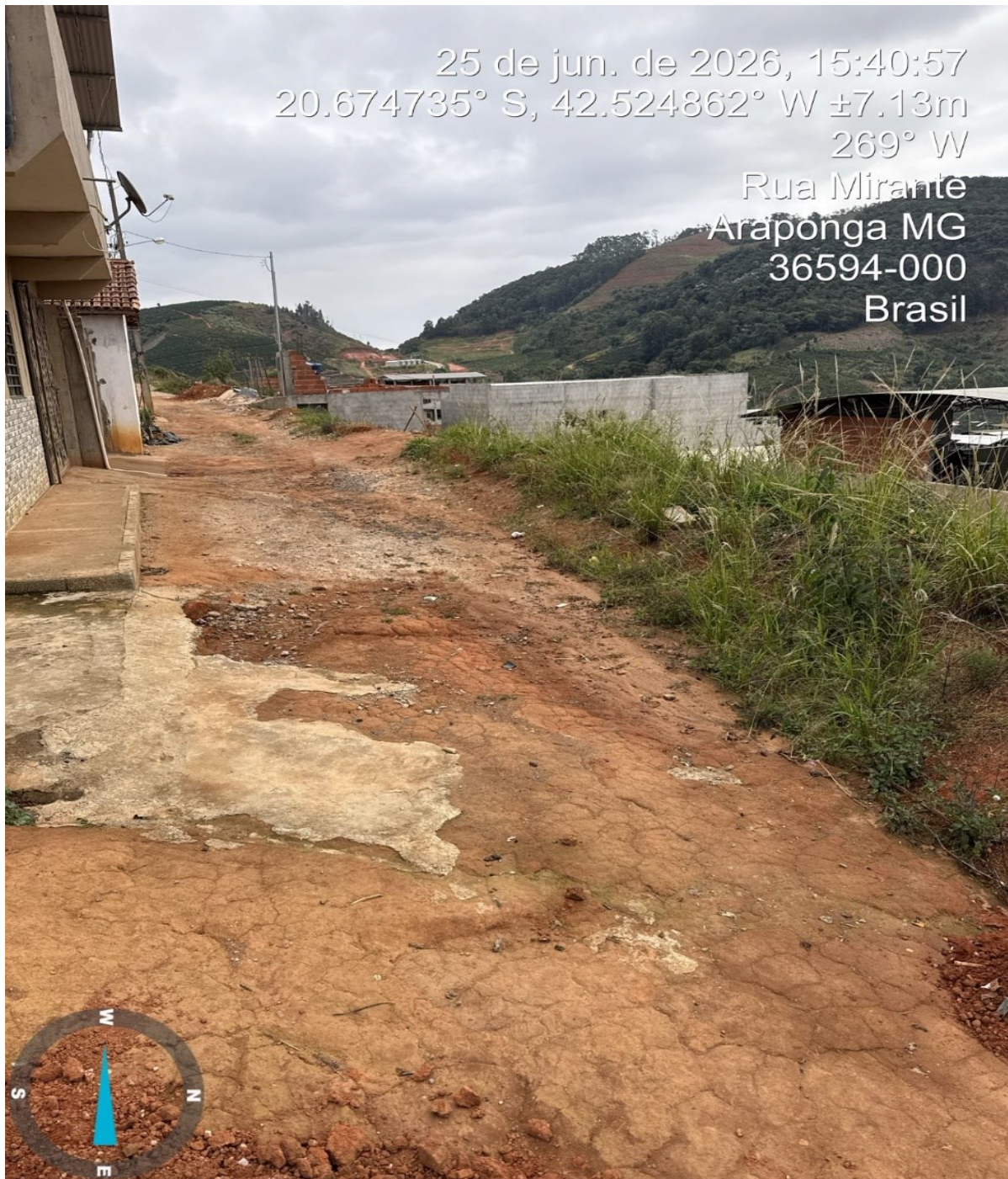
Foto 01 - Trecho inicial da via
